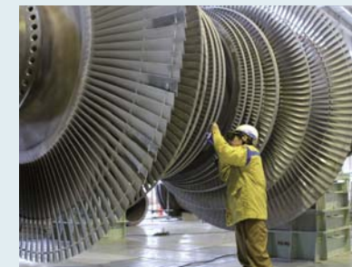
火力発電所定期点検工事の様子
