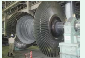
火力発電所定期点検の様子
