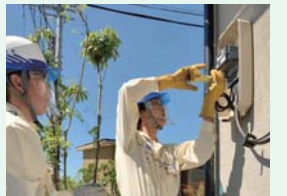
スマートメーター設置の様子
