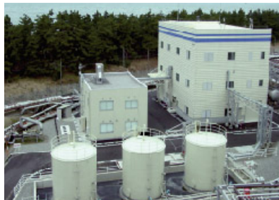
絶縁油リサイクルセンター全景
