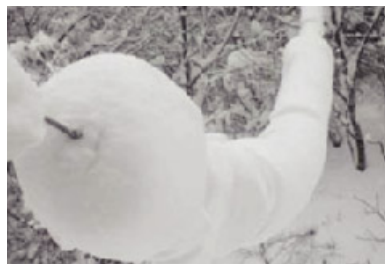
送電線を包み込む着雪。雪の重みで電線が垂れ下がる
