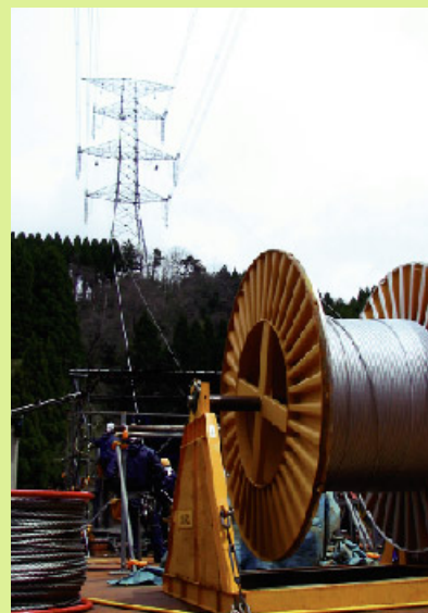
能登幹線復旧工事(架線工事)
