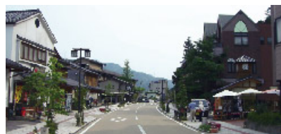
無電柱化事例(石川県加賀市山中町ゆげ街道)
