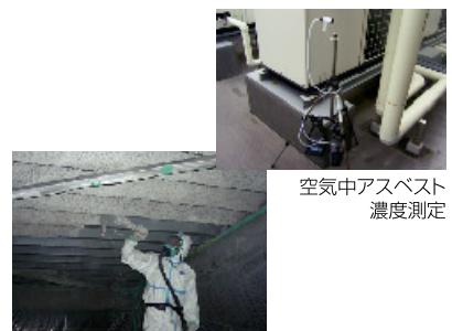
アスベスト除去工事
