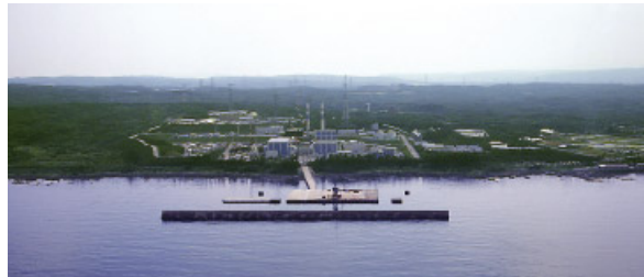
志賀原子力発電所周辺
