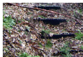
巡視路階段杭
