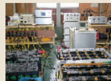
鉛蓄電池の再生の様子
