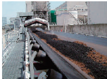
石炭運炭ベルコン(石炭と木質バイオマス混合状況)
