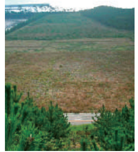
建設工事終了後
