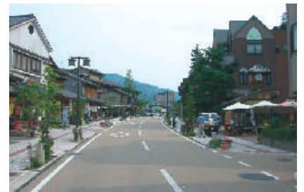
無電柱化事例（石川県加賀市山中町ゆげ街道）
