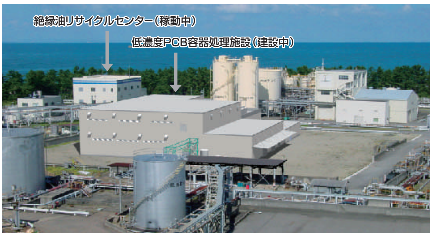
絶縁油リサイクルセンターおよび低濃度PCB容器処理施設(合成写真)
