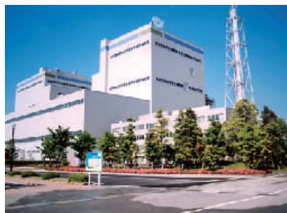
七尾大田火力発電所
