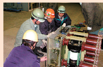
大容量遮断器点検研修
