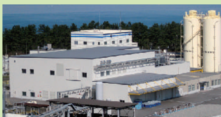
変圧器リサイクルセンター全景
