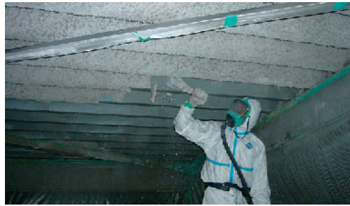
アスベスト除去工事
