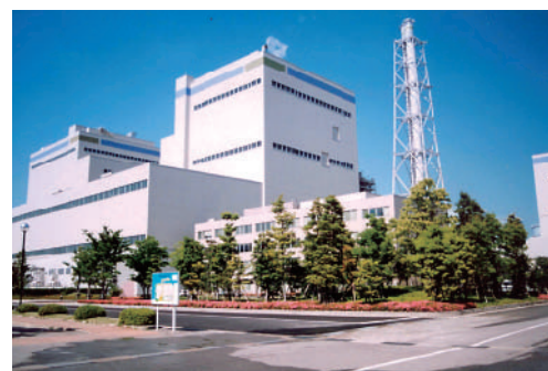
七尾大田火力発電所
