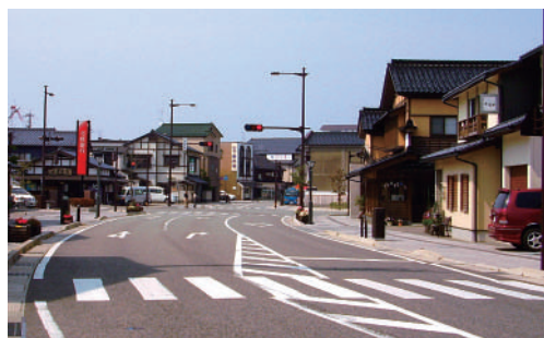
無電柱化事例（輪島市河井町）
