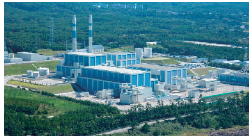
志賀原子力発電所
