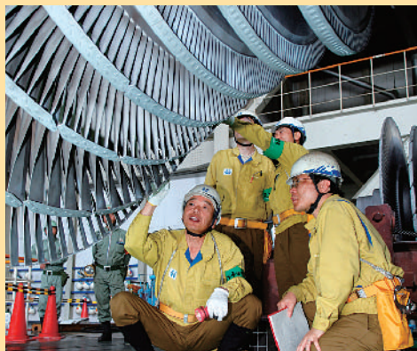
火力発電所定期検査
