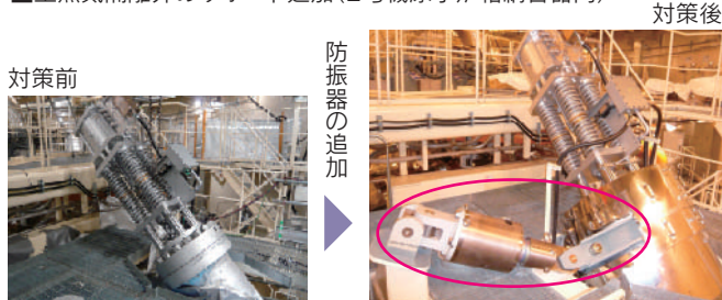
■ 主蒸気隔離弁のサポート追加(2号機原子炉格納容器内)
