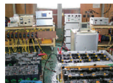
鉛蓄電池の再生の様子
