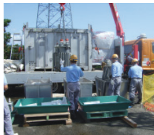
高濃度PCB機器搬出作業
