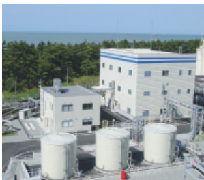
絶縁油処理施設
