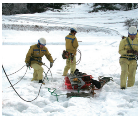
切れた電線を修理する断線復旧訓練
