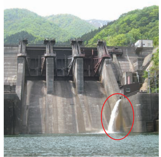
河川維持放流の状況(仏原ダム)
