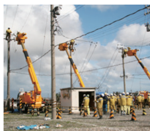
配電工事安全技能大会
