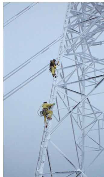
雪の積もった鉄塔での搭上訓練
