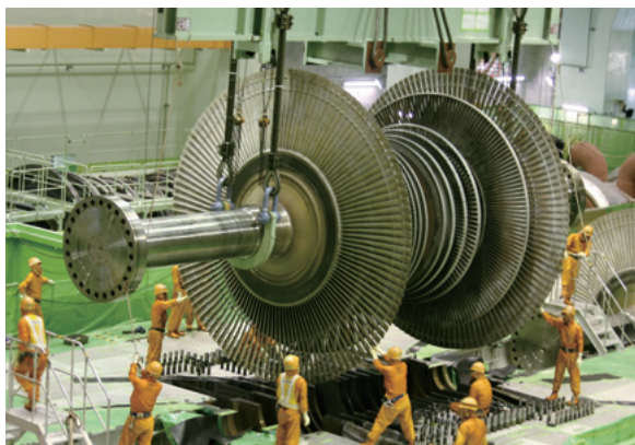
低圧タービンの点検(2号機)
