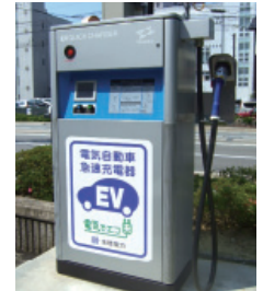
急速充電装置
