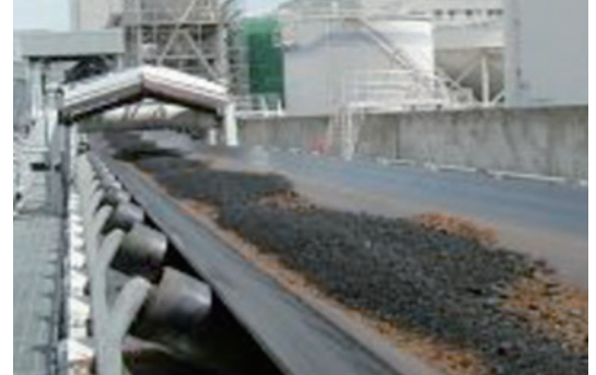
木質バイオマス燃料搬送状況(敦賀火力発電所)
