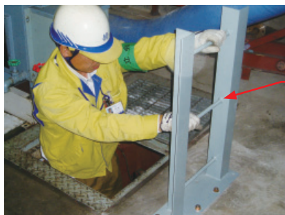
水力発電所内にあるピットへの墜落防止のため、昇降ステップを設置
