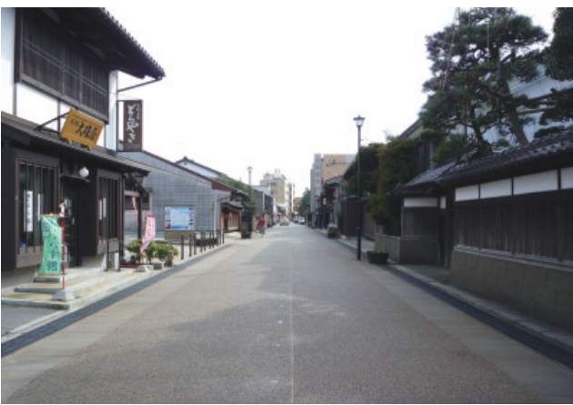
無電柱化事例(富山県富山市 岩瀬大町)
