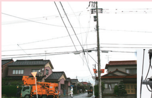
倒木によって電柱が傾く被害や飛来物などによる配電線の断線が続出
