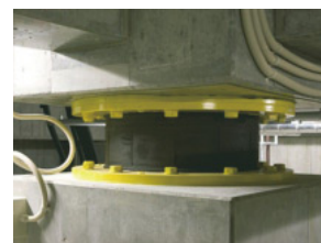
免震装置(積層ゴムアイソレータ)
