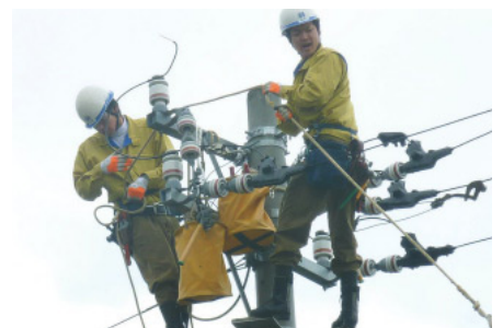
配電工事安全技能大会
