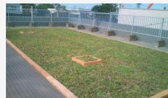
小松支社屋上に設置した緑化材
