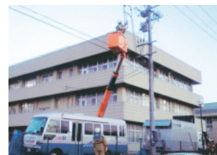
避難所への仮送電作業(宮城県石巻市内にて)
