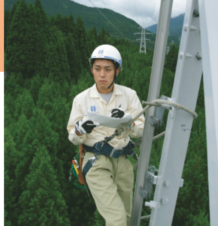
送電線巡視による樹木離隔距離の確認
