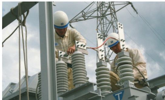
移動変圧器設営研修
