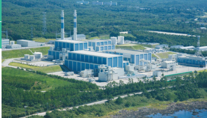
志賀原子力発電所
