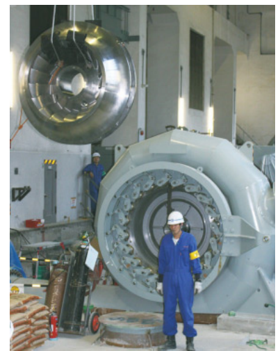
尾口発電所1・2号発電機取替
