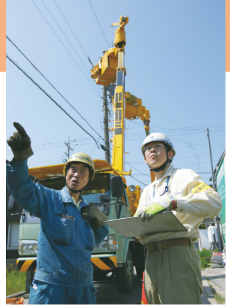
配電線工事現場の安全/パトロール
