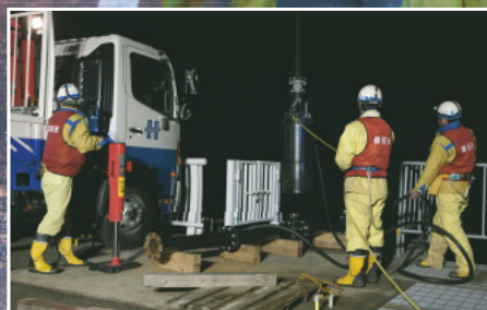
大坪川ダムに水中ポンプを設置
