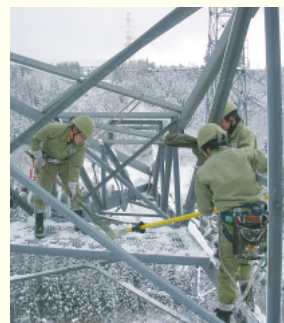
着雪した鉄塔での除雪訓練
