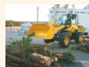
がれき撤去訓練の様子
