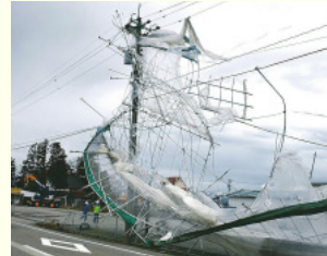
強風による配電線被害
