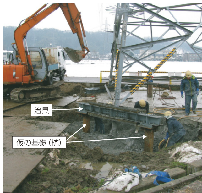
仮基礎と治具の使用状況
