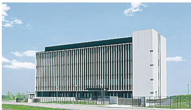
データセンター外観
