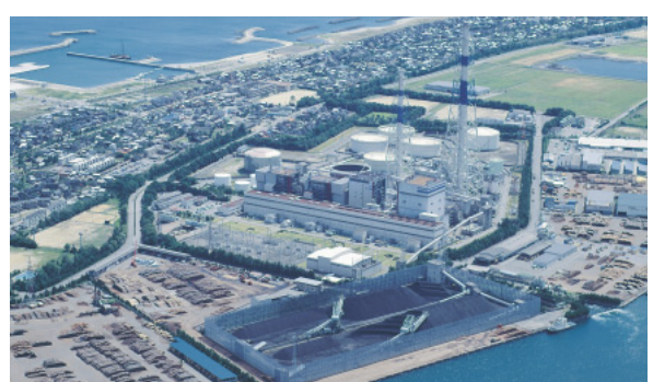
富山新港火力発電所
