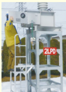
発電所機器高所点検を正しい姿勢で行えるようワンタッチ式梯子を設置
