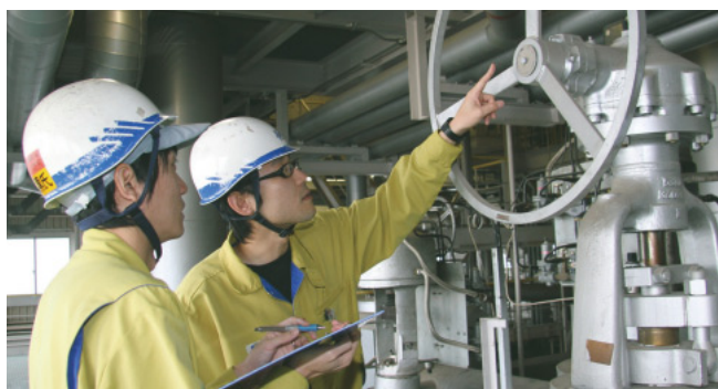
設備機器点検
