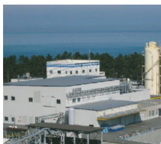
変圧器リサイクルセンター
