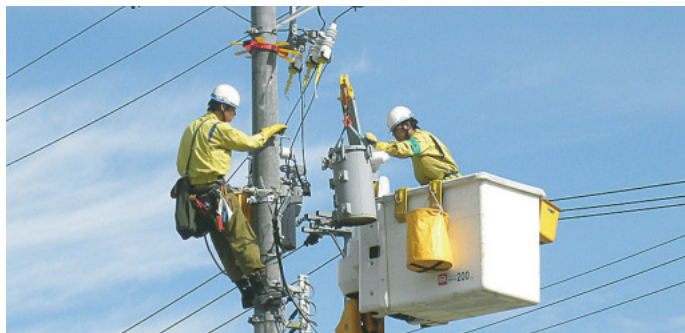
配電工事安全技能大会
