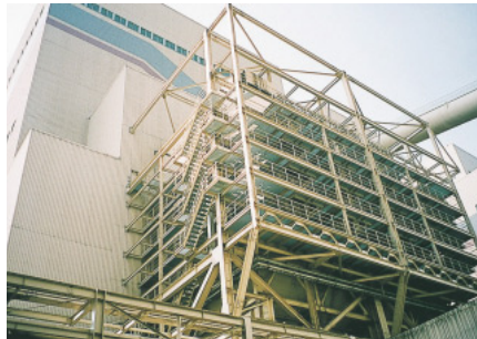
排煙脱硝装置(敦賀火力発電所)
