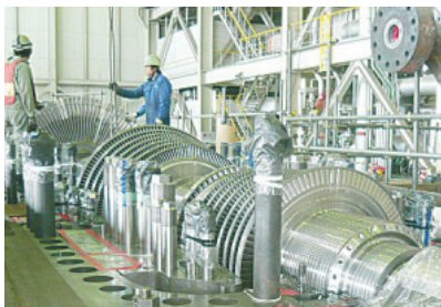
高中圧タービンロータ取付状況
