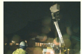
夜間の復旧作業
