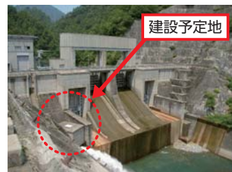
北又ダム発電所建設予定地
