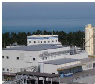
変圧器リサイクルセンター
