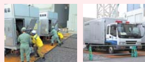
電源接続訓練の様子 電源車
