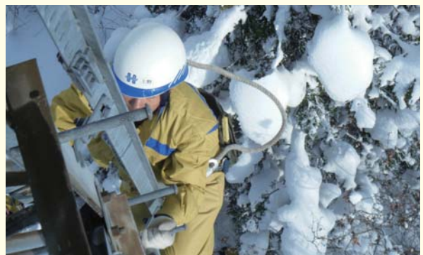
鉄塔昇塔訓練
