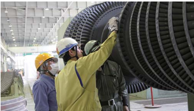
火力発電所タービン点検
