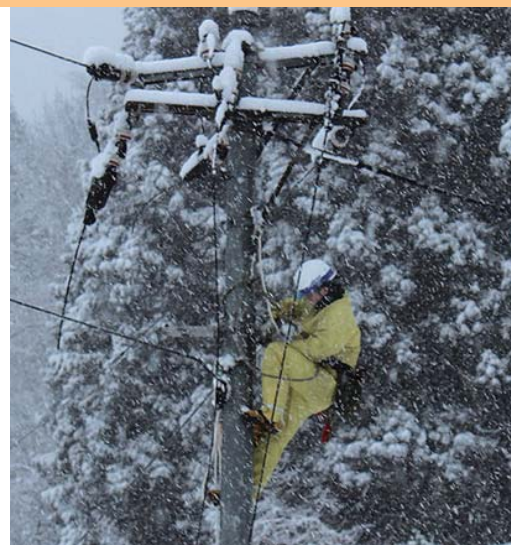
厳冬期での断線復旧訓練
