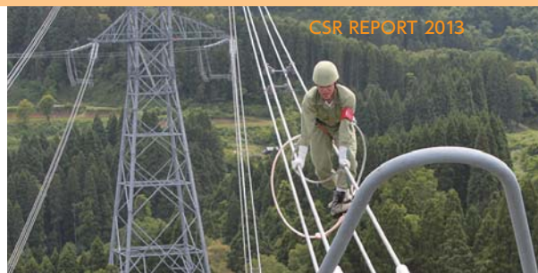
500kV送電線 電線乗出し訓練
