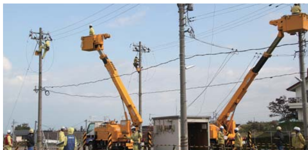
配電工事安全技能大会
