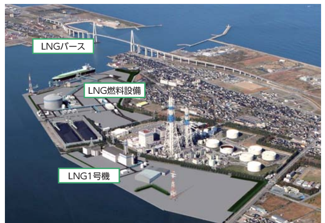
富山新港火力発電所LNG1号機イメージ図
