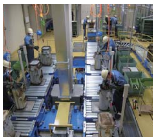
容器処理施設内の様子
