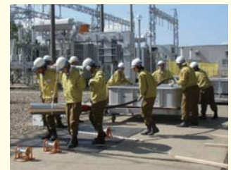
バイパス移動ケーブル設置訓練
