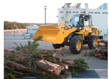
がれき撤去訓練の様子
