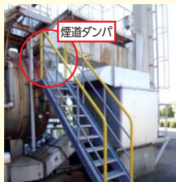
煙道ダンパを安全に操作するため、ハシゴを撤去し、階段を設置
