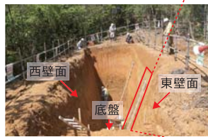
敷地外トレンチ掘削状況
