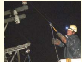
復旧作業の様子
