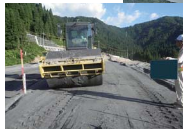
道路(国道)軽量盛土材
