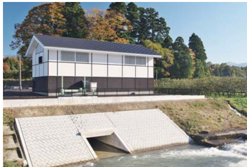
山田新田用水発電所(放水口側)
