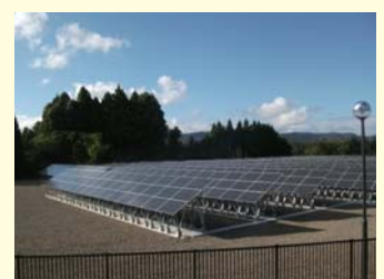
珠洲太陽光発電所の建設工事
