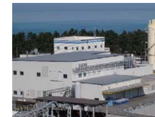
変圧器リサイクルセンター
