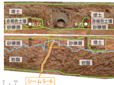
シームS-6のトレンチ調査
