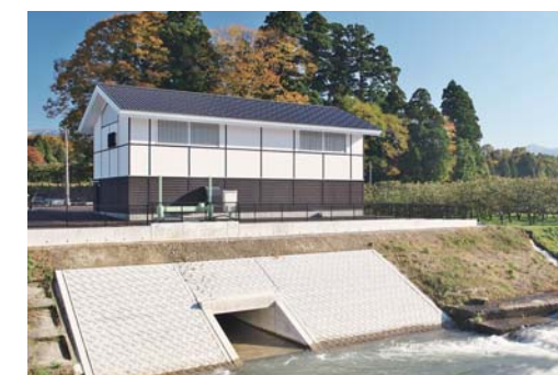
山田新田用水発電所(放水口側)
