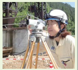
構造物の出来上がり高さの検査の様子
