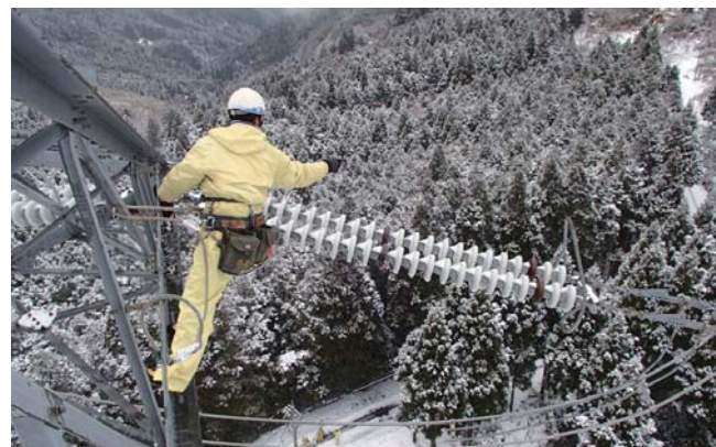
技術マスター指導による鉄塔点検
