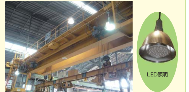
工場内LED照明に取替
