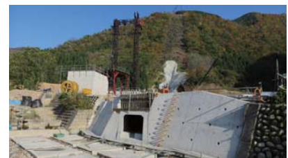
片貝別又発電所建設工事現場
