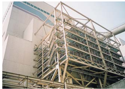
排煙脱硝装置(敦賀火力発電所)
