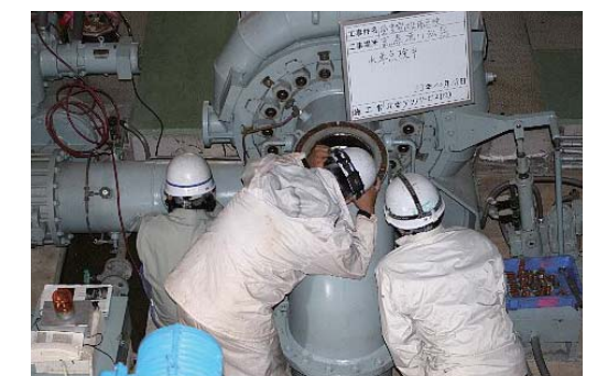
小水力発電所の水車外部点検作業
