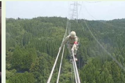
送電線での宙乗り点検
