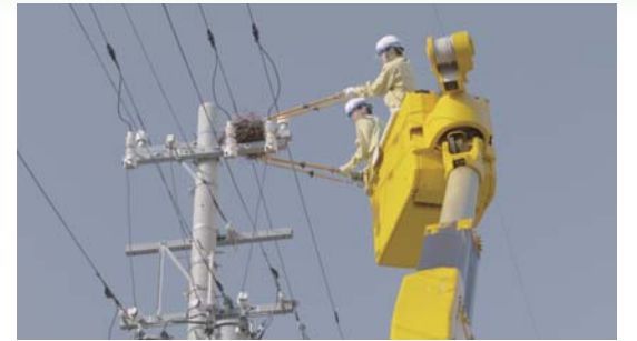
宮集撤去作業
