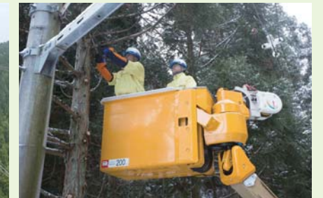
配電線に接近した枝の伐採
