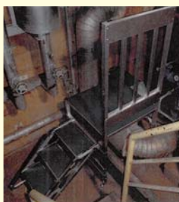
ポンプの巡視点検時に配管を跨いでの転倒を防止するため階段を設置
