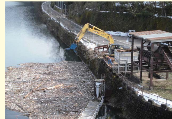
ダムに流れ込んだ流木・ゴミの回収
