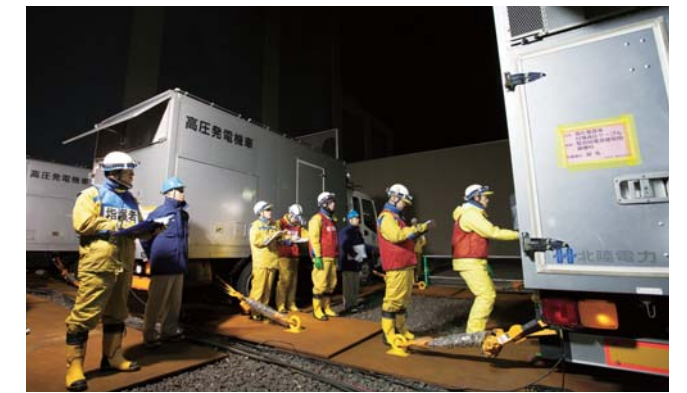
夜間の電源接続訓練
