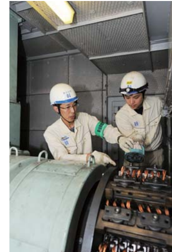
火力発電所での巡視点検
