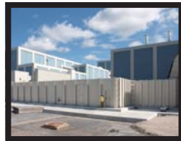
防潮壁の設置 ②
