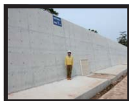
防潮堤の設置 ①
