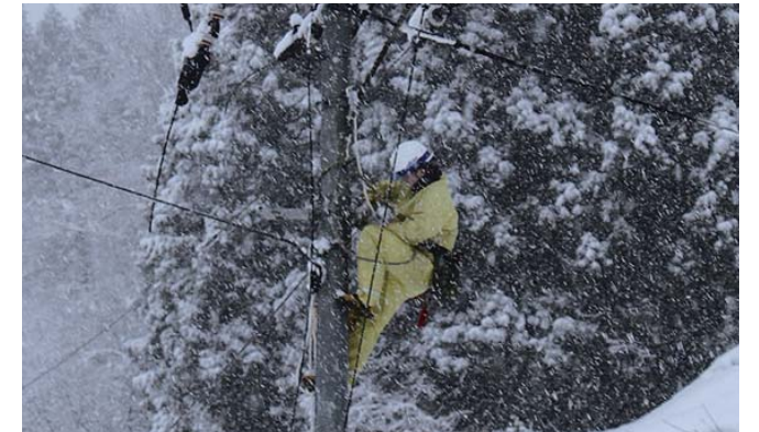
厳冬期での断線復旧訓練
