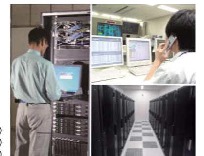
左：システムオペレーション作業の様子(北電情報システムサービス) 右上：通信回線の運用監視作業の様子(北陸通信ネットワーク) 右下：データセンターのハウジングラック群(パワー・アンド・IT)
