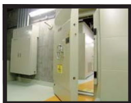
水密扉の設置 ③
