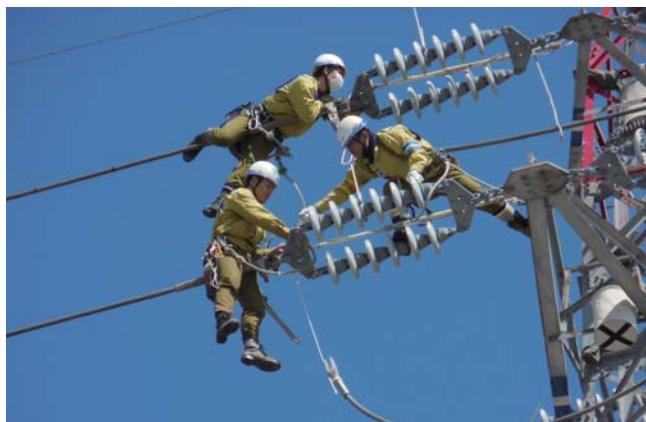
送電線事故復旧訓練
