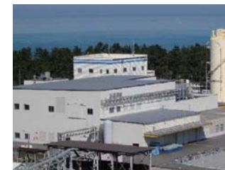
変圧器リサイクルセンター
