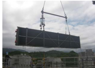
ガスガスヒーター更新(敦賀火力発電所2号機)
