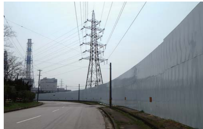
仮設防音壁の設置状況
