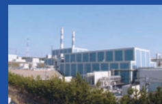
志賀原子力発電所2号機
