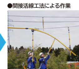
● 間接活線工法による作業
