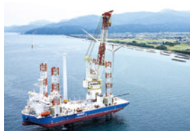
自己昇降式作業台船 (SEP 船) による海上施工の様子
