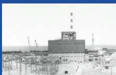
富山火力発電所1号機
