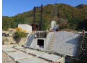
片貝別又発電所件背湯工事現場
