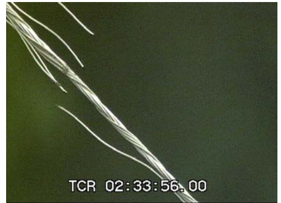
写真1 素線切れの状況（一例）
