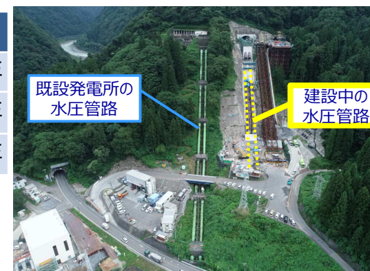
新姫川第六発電所の建設状況 (2021年8月、新潟県糸魚川市)
