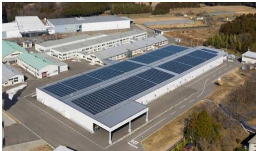
福井鋳螺(株)さまに導入いただいた太陽光発電設備
