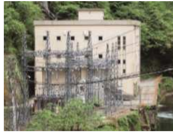
上寺津発電所
