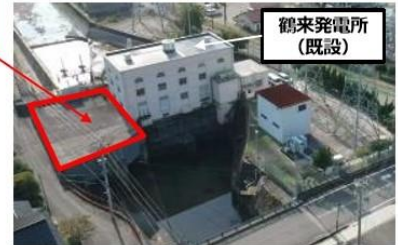
鶴来古町発電所の全景
