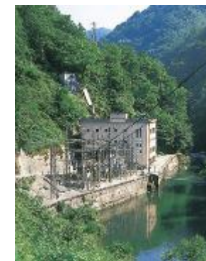
上寺津発電所
