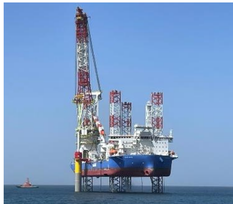
自己昇降式作業台船（SEP船）による海上施工の様子
