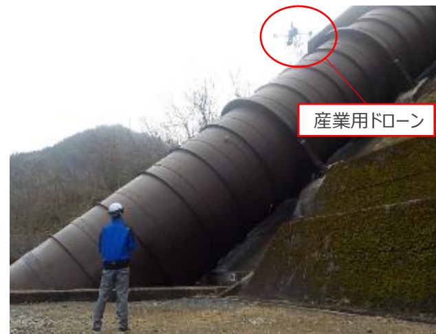
ドローンによる水圧鉄管の巡視点検状況（水力）
