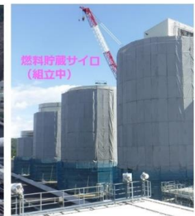
七尾大田火力発電所 工事状況 ・燃料貯蔵サイロ設置工事中 ・輸送コンベヤ設置工事中
