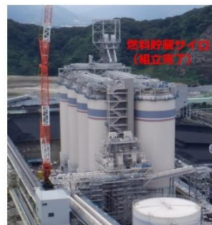
敦賀火力発電所 工事状況 ・燃料貯蔵サイロ設置完了 ・輸送コンベヤ設置工事中
