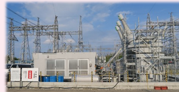
<微量PCB含有機器の加熱洗浄処理>
