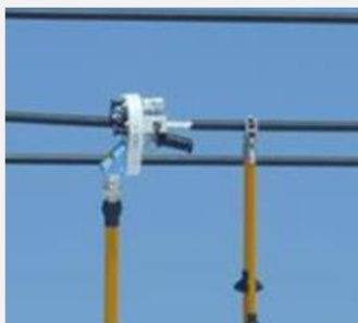
①電線被覆の剥ぎ取り
