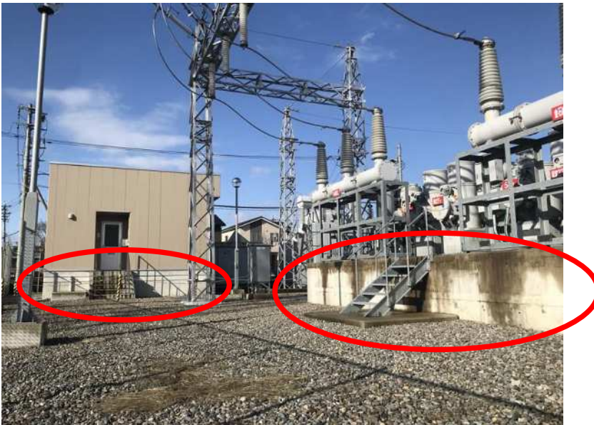
建物および開閉装置の嵩上げ
