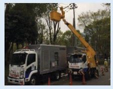
電源車による災害時の復旧作業
