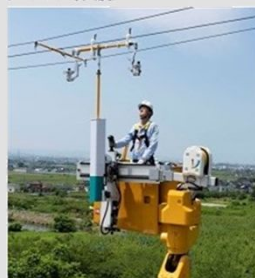
配電工事用ロボット（アシストアーム）の適用
