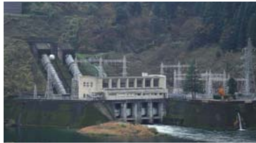
神通川第一発電所
