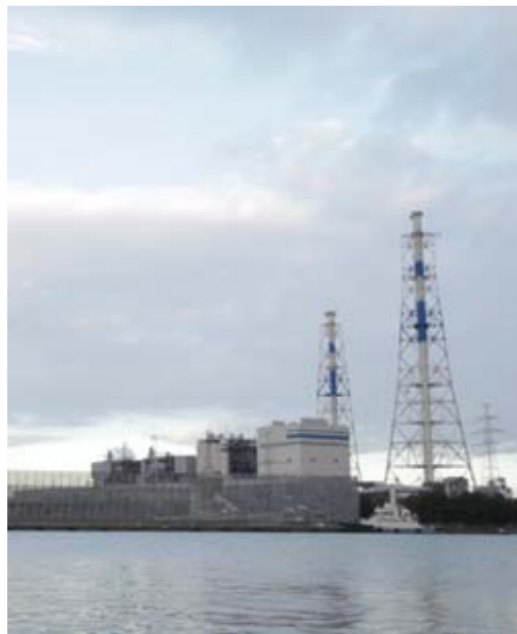
富山新港火力発電所
