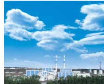
志賀原子力発電所
