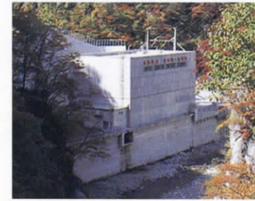
▲有峰第一発電所 水車1基の出力(26.5万kW)が日本で最大の一般水力発電所
