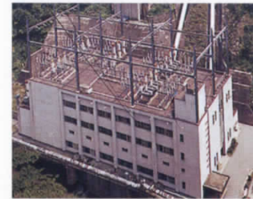
▲和田川第二発電所 昭和61年6月末に最後に無人化された水力発電所
