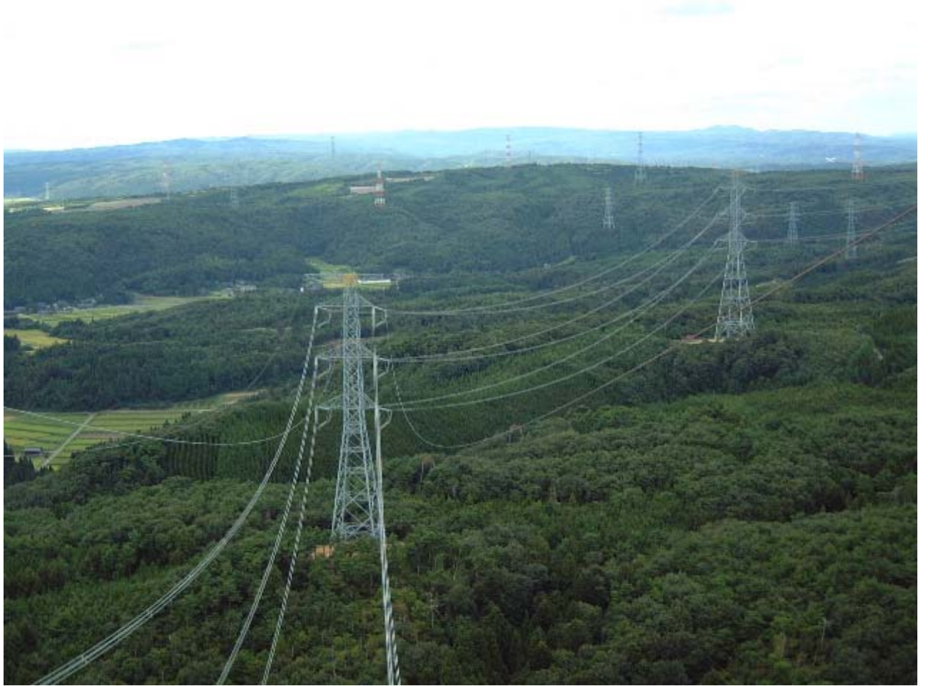
志賀中能登線の完成写真
