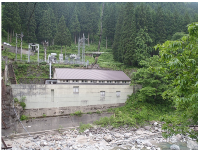
中宮発電所 本館
