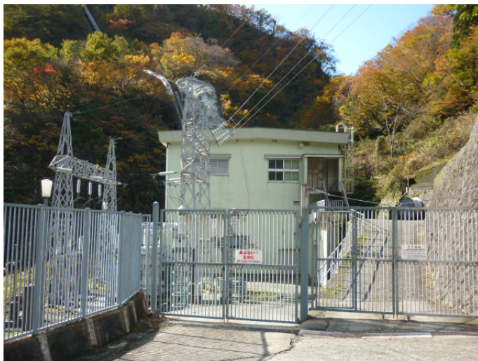
境川第三発電所 本館
