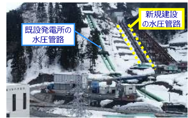
新姫川第六発電所
