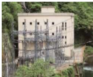
上寺津発電所
