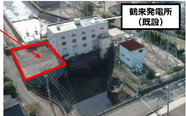
鶴来古町発電所の全景
