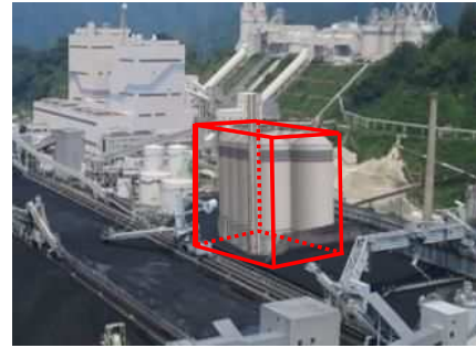
バイオマス燃料貯蔵サイロのイメージ（敦賀火力発電所）
