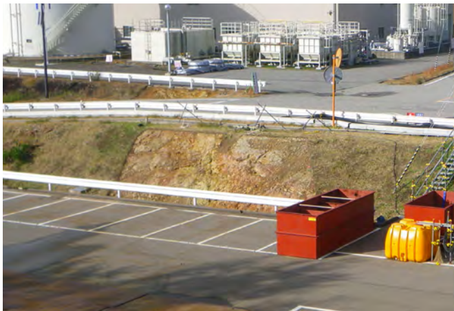
駐車場北側法面付近状況写真
