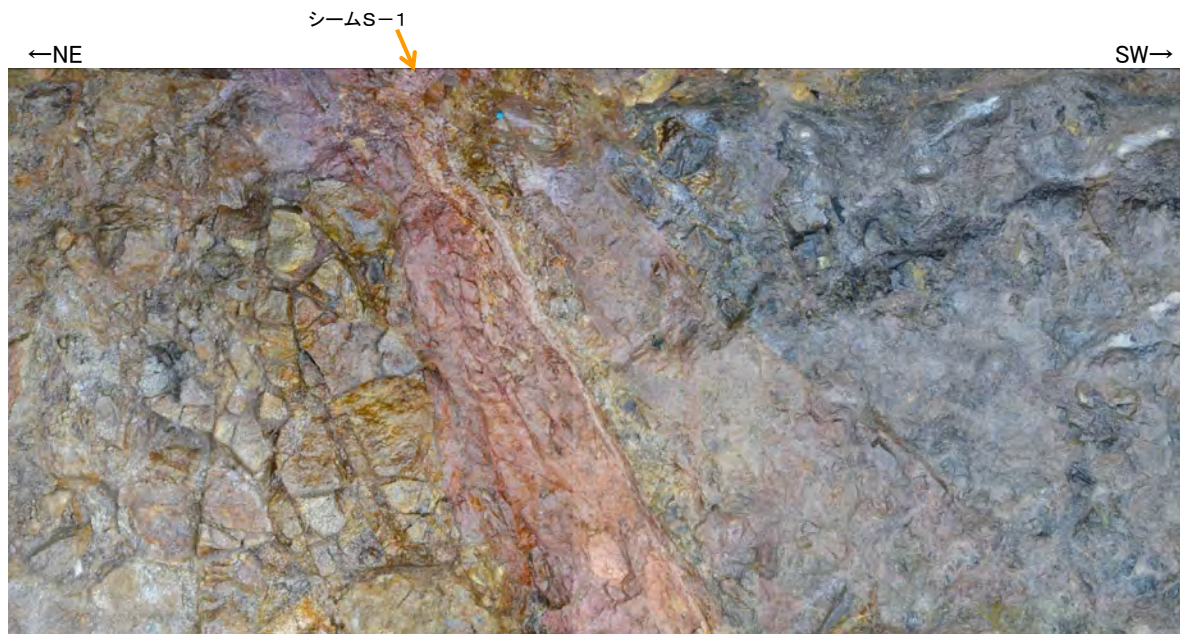
底盤写真(シームS-1付近)
