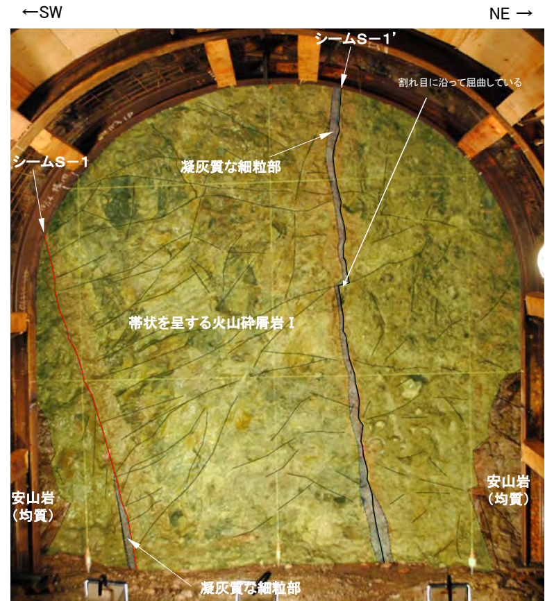
No.13切羽写真(割れ目等を加筆)
