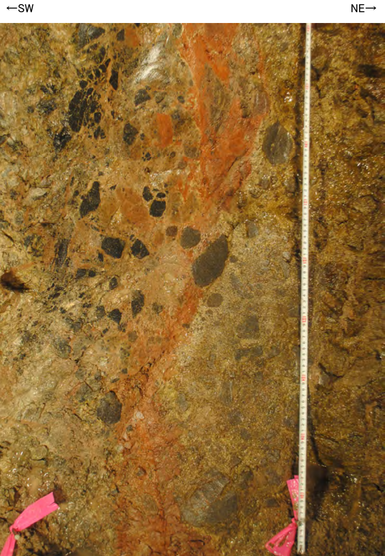
No.13付近底盤写真
