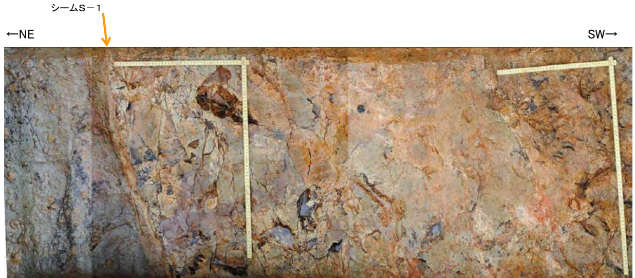
シームS-1 底盤写真(シームS-1付近)
