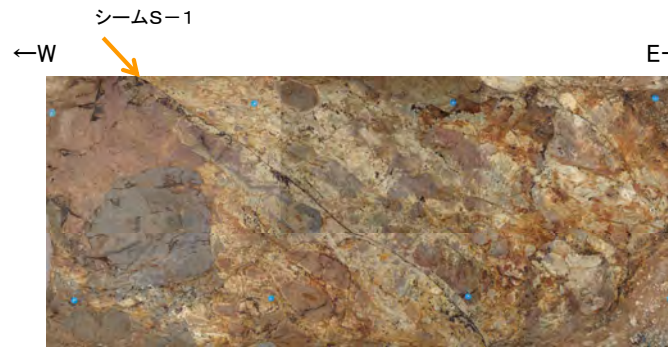
底盤写真 (④トレンチ シームS-1付近) (2013年5月21日撮影)
